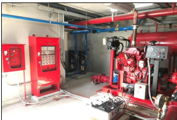
รูปที่ 4 ปั้มน้ำดับเพลิง
