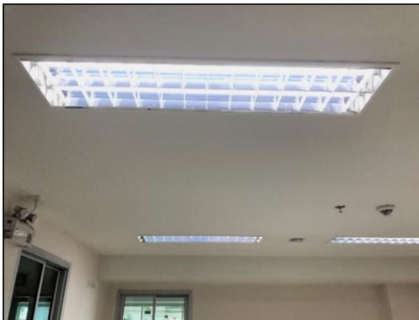
รูปที่ 2 โคมไฟสะท้อนแสง
