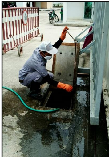
การทำความสะอาดตะแกรงดักมูลฝอย
